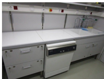
Arbeitsfläche mit Laborspülmaschine
